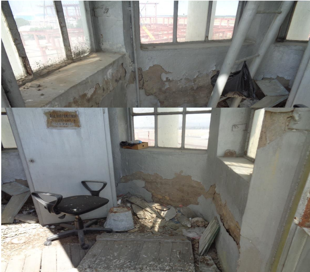
Состояние несущих стен Бельведера
